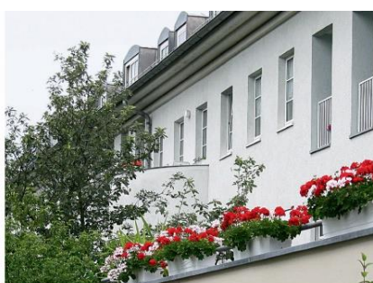
Pflegestation Henlestraße Henlestraße 2A 97074 Würzburg
